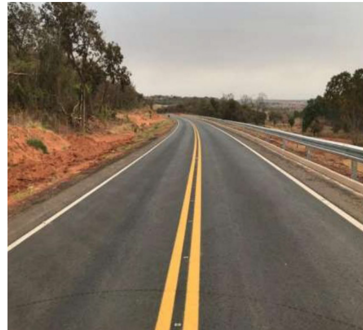
Pavimentação da MS - 223, Trecho entre Figueirão e Costa Rica. Fonte: SEINFRA/FUNDERSUL
