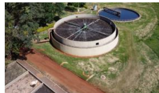
Estação de Tratamento de Esgoto - com utilização de drones. Fonte: Segov/Agems.
